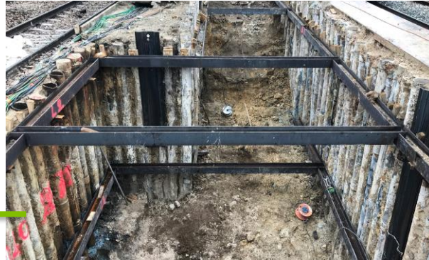
Réalisation d'un blindage près des voies ferrées
