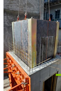
Création d'une cage ascenseur
