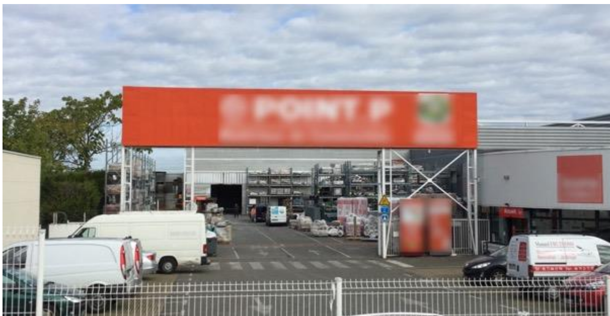
Enseigne scellée au sol de grand format dépassant 12 m 2 (non conforme), Les Clayes-sous-Bois, 2017
