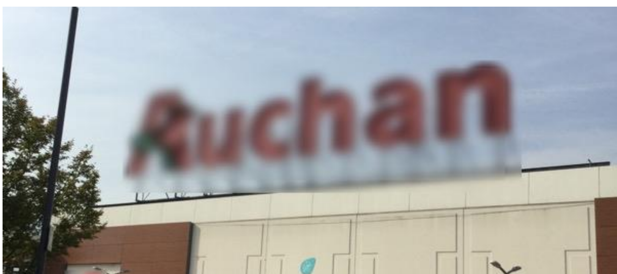
Enseigne sur toiture dépassant les 60 m 2 (non conforme), Maurepas, 2017
