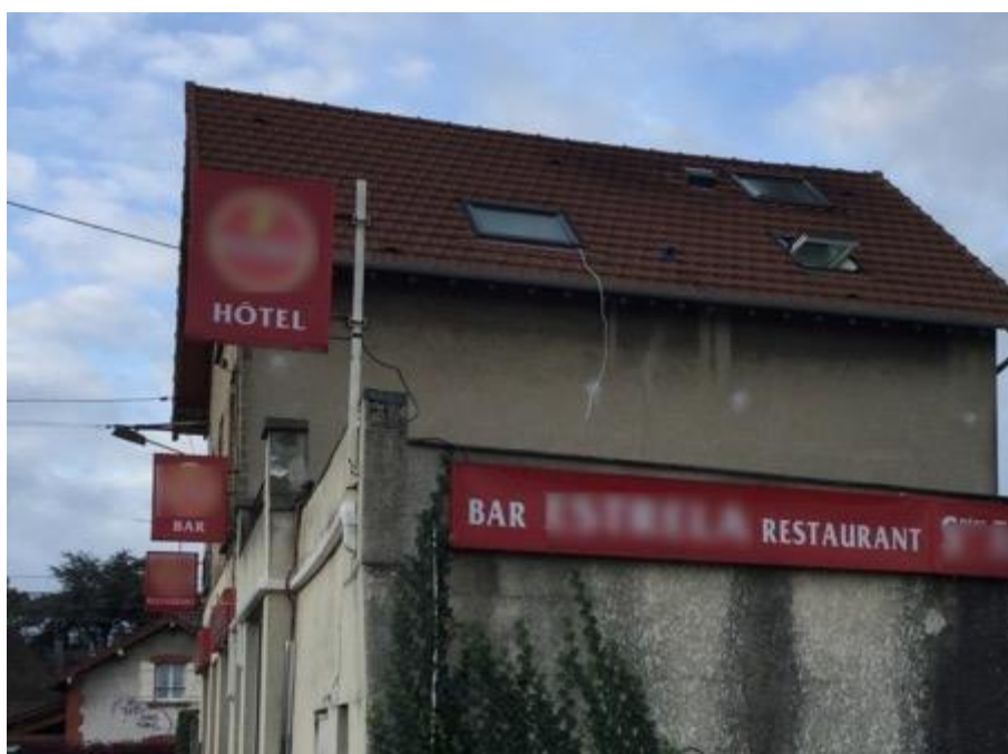
Trois enseignes perpendiculaires en façade dont une dépassant la limite du mur (qui est non conforme), Les Clayes-sous-Bois, 2017
