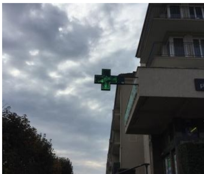
Enseigne perpendiculaire dont la saillie sur domaine public dépasse 2 mètres (non conforme), Maurepas, 2017
