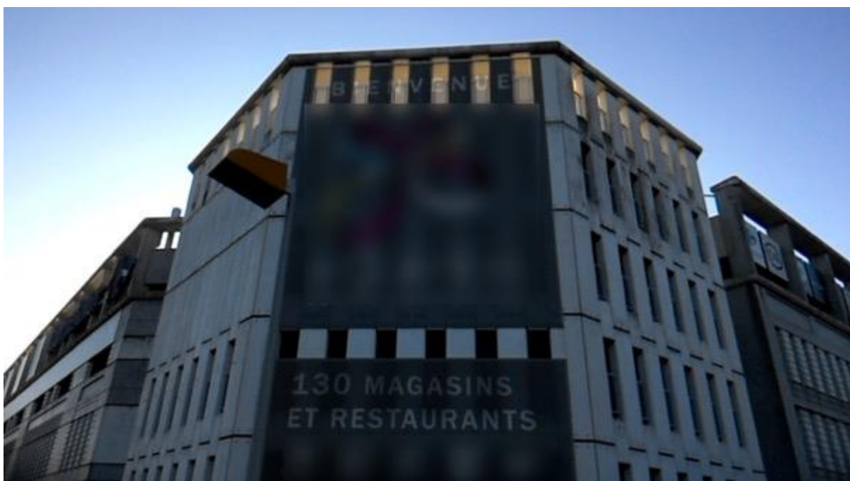
Enseigne parallèle dont la surface dépasse la proportion par rapport à la façade (15%) (non conforme), Montigny-le-Bretonneux, 2017
