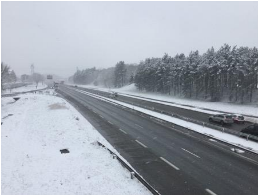
La N10, un axe structurant instaurant une coupure dans le territoire, La Verrière, 2018
