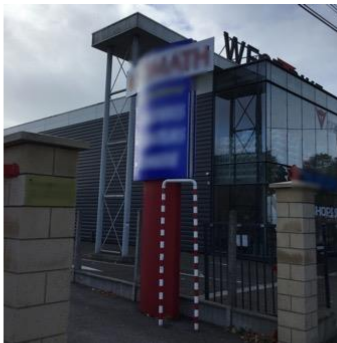
Enseigne scellée au sol implantée sur la limite séparative de propriété sans recul de la moitié de sa hauteur (non conforme), Coignières, 2017
