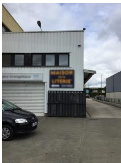
Préenseigne sur un mur non aveugle (non conforme), Les Clayes-sous-Bois, 2017
