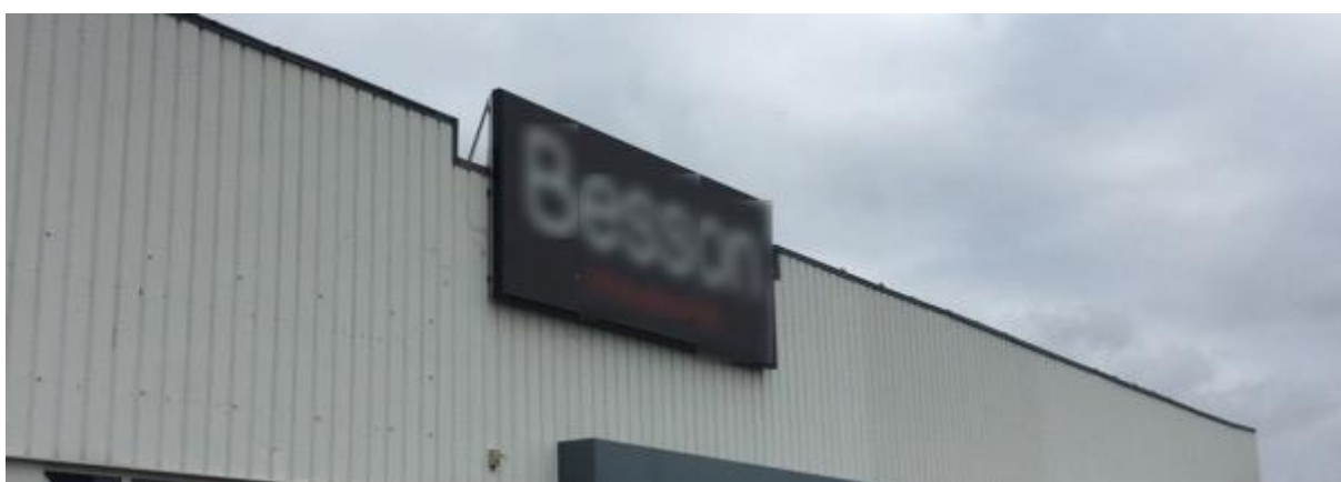
Enseigne parallèle dépassant les limites du mur (non conforme), Coignières, 2017
