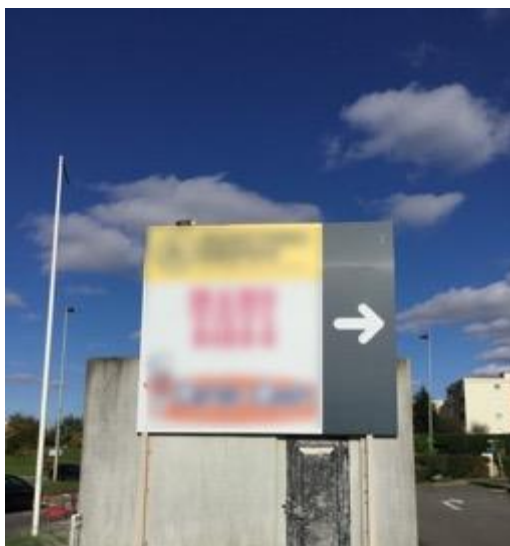
Préenseigne dépassant les limites du mur (non conforme), Coignières, 2017
