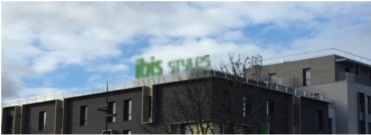
Enseigne sur toiture d'environ 13 m2, Guyancourt, 2017
