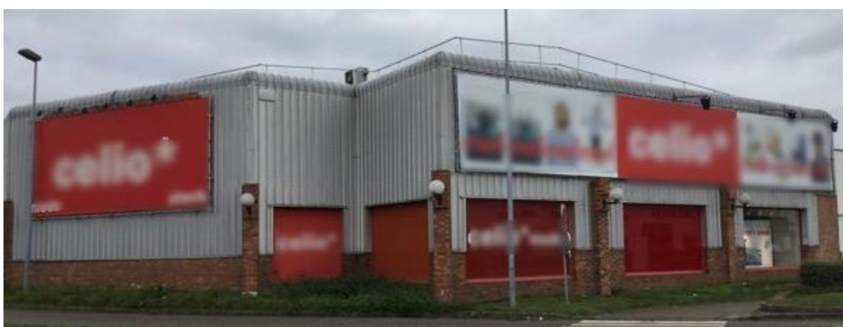
Enseigne parallèle dont la surface dépasse la proportion par rapport à la façade (15%) (non conforme), Coignières, 2017
