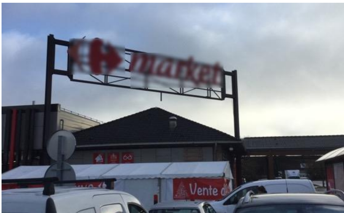
Enseigne scellée au sol de grand format dépassant 12 m 2 (non conforme), Voisins-le-Bretonneux, 2017
