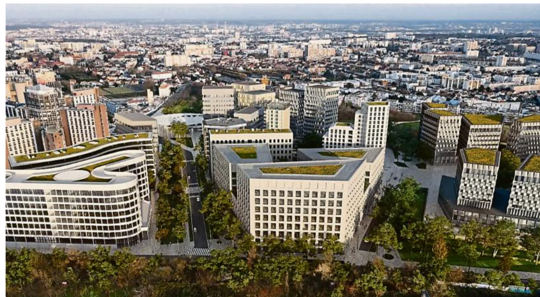
Au premier plan, le bâtiment « The Hive » accueillera huit sociétés dont les industriels Orano Med et Sanofi, la start-up Orakl Oncology et les deux biotech Signadori Bio et Valerio Therapeutics. DR
