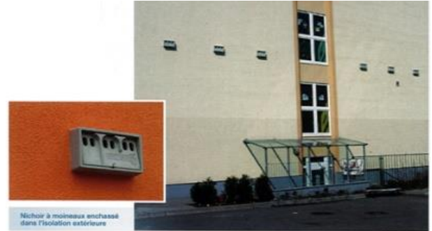
Exemples de nichoirs à oiseaux directement inclus dans l'isolation extérieure de bâtiments – Source : LPO/ CAUE Isère, 2012
