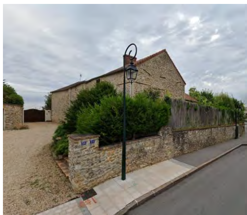
Corps de ferme et son mur remarquable (rue Henri Prou)
