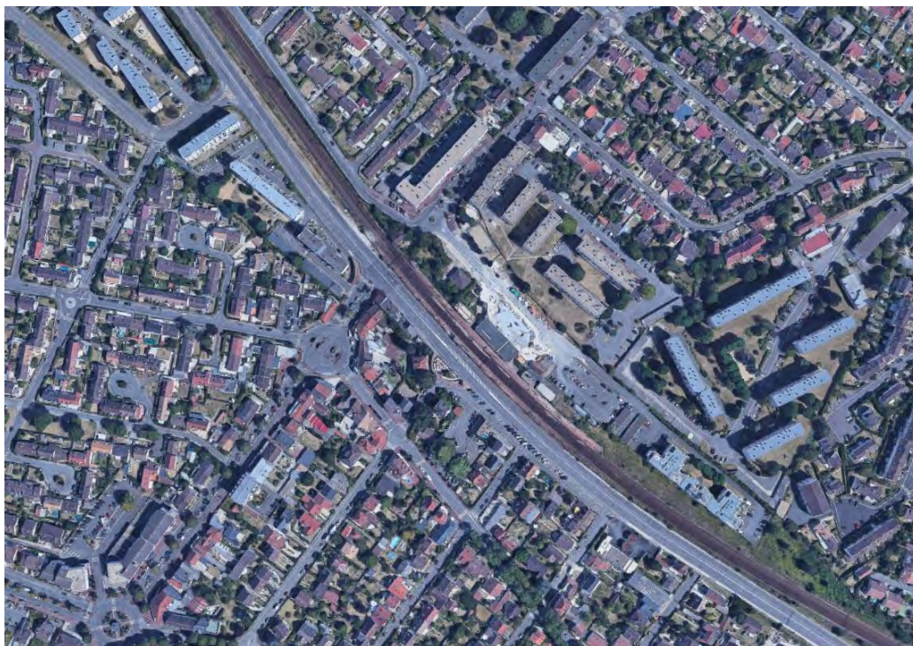
Photographie aérienne du pôle gare lors de la réalisation des travaux sur le parvis de la Gare en 2019
